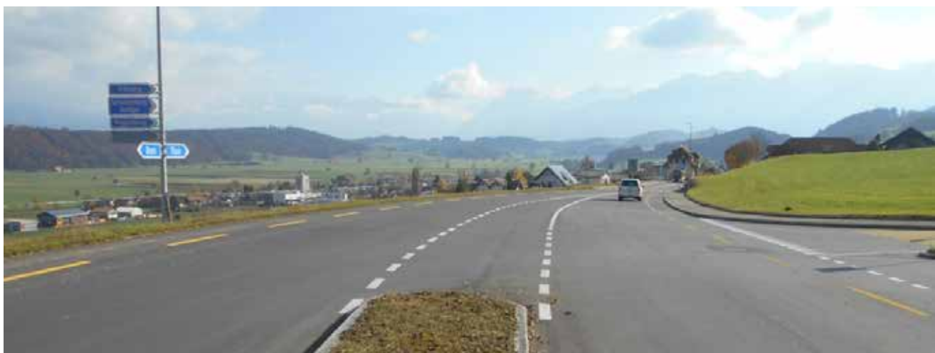
Abb. 3: Blick Fahrtrichtung Thun, Nachher-Situation (Foto TBA Kanton Bern)
