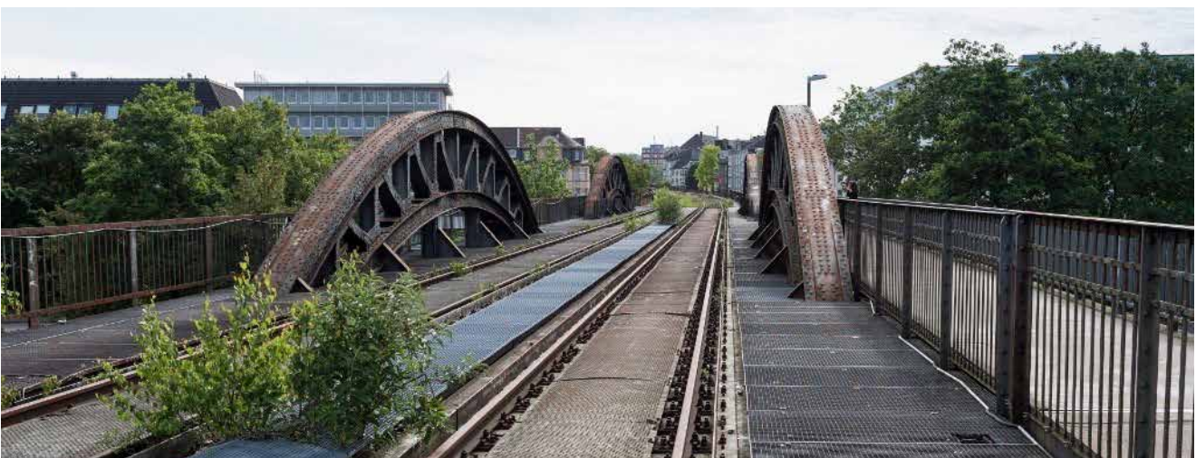
Der alte ungenutzte Eisenbahnviadukt in Essen soll ein Teilstück des RS1 werden.
