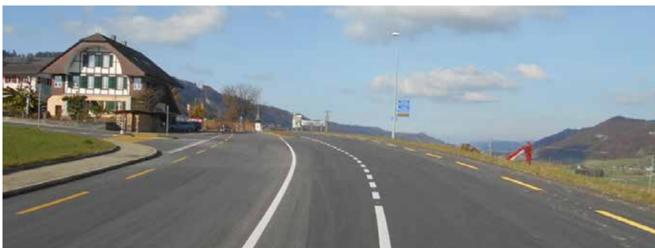
Abb. 4: Blick Fahrtrichtung Bern, Nachher-Situation (Foto TBA Kanton Bern)
