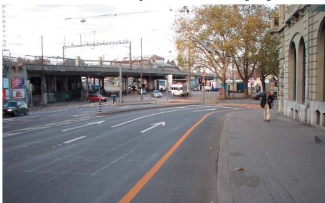
Bollwerk, Bern: Die neuen Radstreifen erhöhen die Verkehrssicherheit für Velofahrende.
