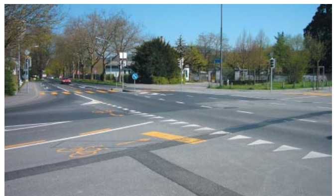
Point d'arrêt marqué au sol pour tourner-à-gauche indirect, avec arrêt intermédiaire sur le bord droit
