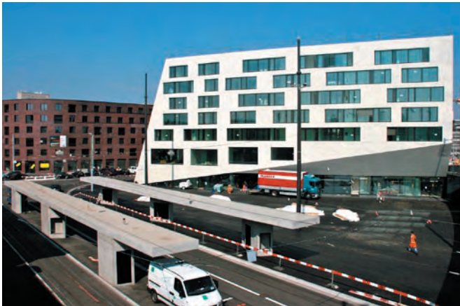
Vogesensplatz und Volta Zentrum kurz vor Bauabschluss Vogesensplatz et Volta Zentrum peu avant la fin du chantier
