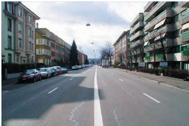
Vor und nach Umgestaltung des Wasgenrings Avant et après la requalification du Wasgenring
