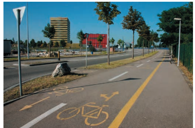
Radweg mit Querung über Schlachthofstrasse Piste cyclable avec traversée de la Schlachthofstrasse
