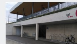
Visibilité en entrée de gare | Münchenwiler-Courgevaux Source : Bîno für Mobilität SA
