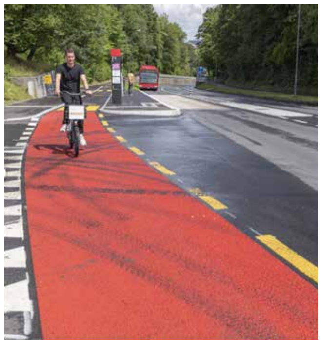
Fig. 2 L'arrêt, situation après réaménagement
