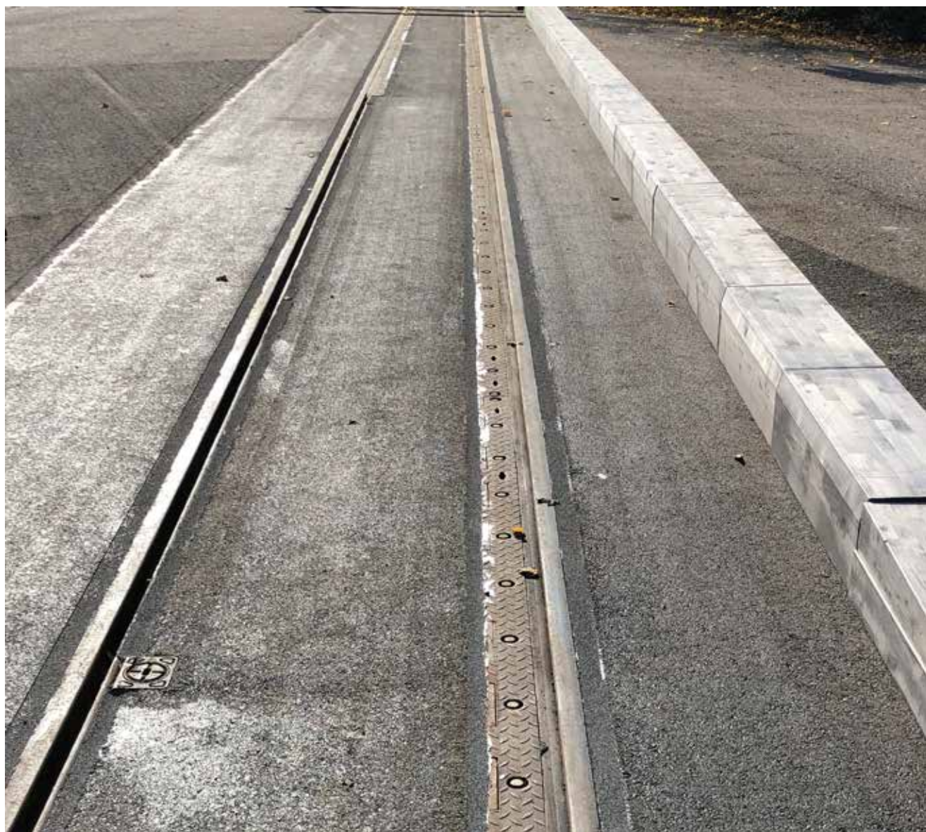
Rail colmaté pour éviter que les roues des vélos ne s'y coincent
