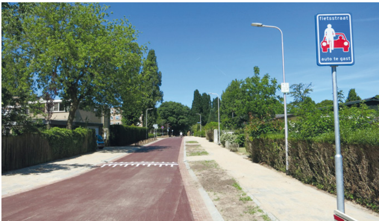
Rue cyclable à Nijmegen (Pays-Bas) avec le panneau de signalisation très répandu « auto te gast » (voiture = invité) et le revêtement rouge ; à noter les bords inclinés servant de ralentisseurs, mais restant franchissables par les vélos.
