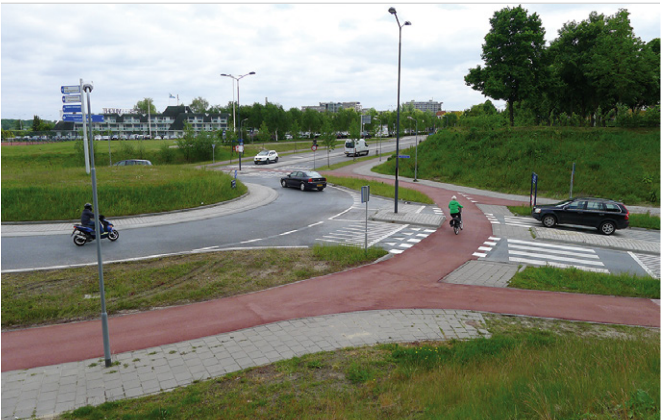
Fig. 10: Infrastructure simple et intuitive (photo: planum biel ag)
