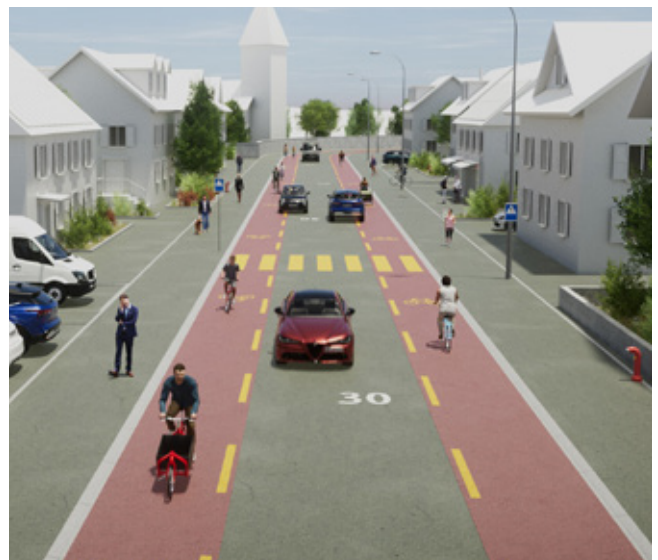
Fig. 7 : Comparaison des coupes-types « avant – après » pour une largeur de 7,50 m, et visualisation correspondante (visualisation : Conférence Vélo Suisse / co.dex production ltd. & Julien Joliat)
