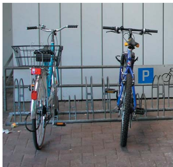
Vorderräder hoch / tief versetzt. Zu enge Anordnung. Abstand der Velos im System <45cm. Es wird nur jeder zweite Platz gezählt.
