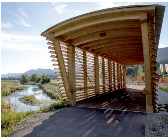
Déplacement de l'itinéraire sur une longueur de 5 km et construction de deux nouvelles passerelles dans la région d'Olten (Photos : SuisseMobile)
