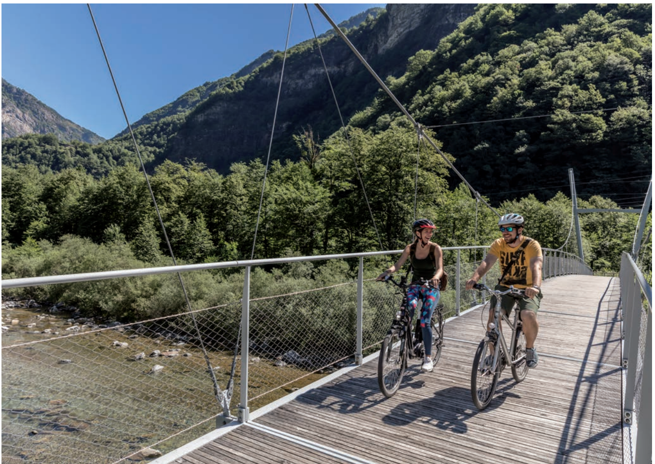
Figure 1 : passerelle entre Cevio et Bignasco
