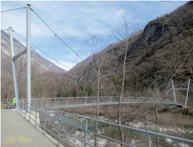
Figure 7 : nouvelle passerelle cyclable et pont en pierre historique à Bignasco
