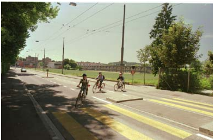
1b. Abbiegehilfe auf Schulweg (Veloroute See-Länggasse)
