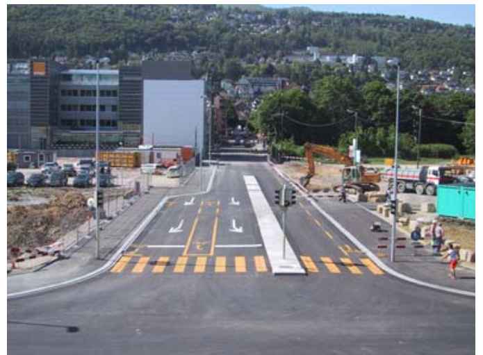
2g. Neubau Kreuzung Neumarktstr./Silbergasse (DTV ca. 15'000)
