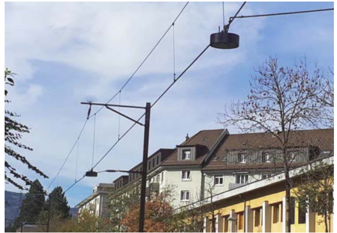
Beleuchtung Langsamverkehrsachse, Montage an Oberleitung der ehemaligen Zentralbahn
