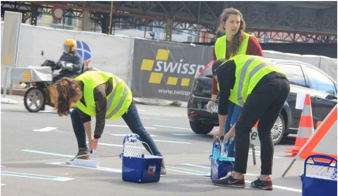
Die Baustelle: Markieren der Symbole auf dem Bahnhofplatz (Foto: Franziska Meinherz)
