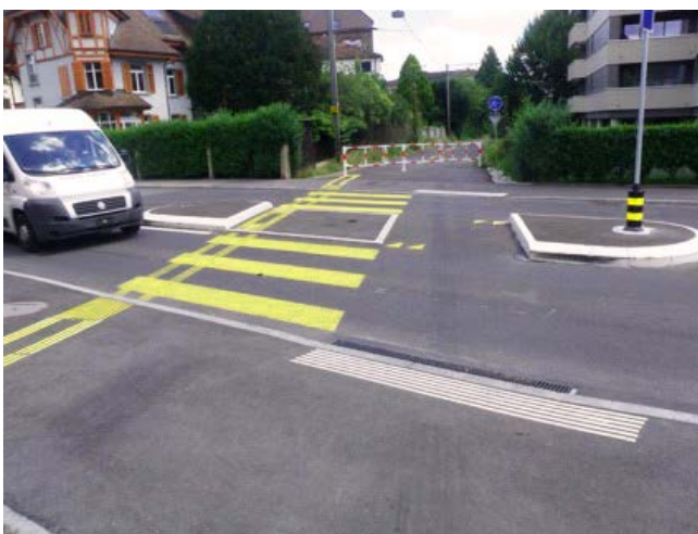
Kreuzung K32 Horwerstrasse
