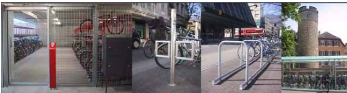
Station Vélo Biel/Bienne et stationnement vélo en ville
