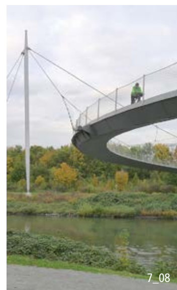
Brücken können als Merkmale im Orts- und Landschaftsbild gestaltet werden (Deutschland).
