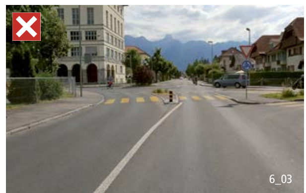
Der Durchschuss erhöht die Geschwindigkeit im Kreisel.
