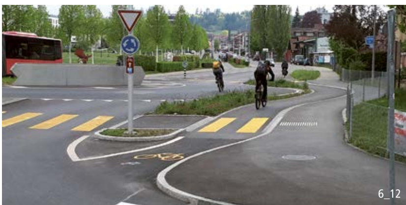
Velobypass in 3-Arm-Kreisels ermöglicht sichere und komfortable Durchfahrt ohne Vortrittsentzug.
