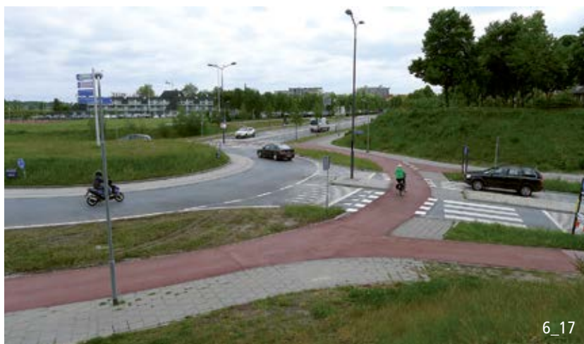
Abgesetzter Einrichtungradweg mit vortrittsberechtigter Führung (Niederlande).
