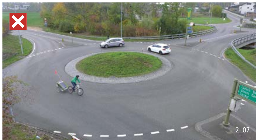
Gefahrenstelle wegen unkorrekter Geometrie: zu breite Kreiselfahrbahn und Durchschuss führen zu hoher Geschwindigkeit des MIV.
