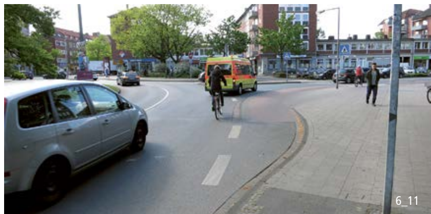
Der Velobypass schützt den Kreiseln verlassende Velofahrende vor dem Kurvenschneiden der ausfahrenden Fahrzeuge.
