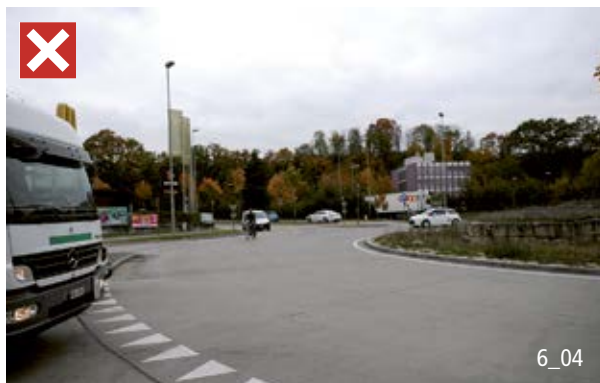
Eine zu breite Kreiselfahrbahn mit zu kleinem Kreiselzentrum und ungenügender Anhebung des Innenrings ist nicht veloverträglich.
