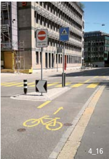
Treninsel als Einfahrt in Einbahnstrasse in Gegenrichtung.
