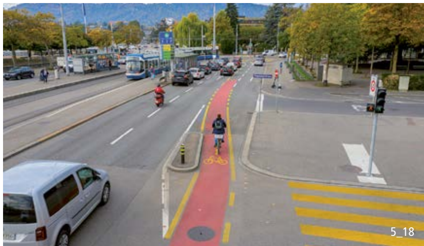
Additionsprinzip Rechtsabbiegestreifen. Die bauliche Massnahme verhindert, dass Motorfahrzeuge den Streifen zu früh befahren.
