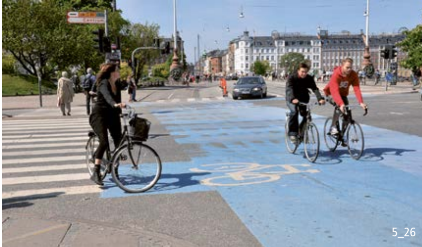
Indirektes Linksabbiegen als Knotensystem (Dänemark).
