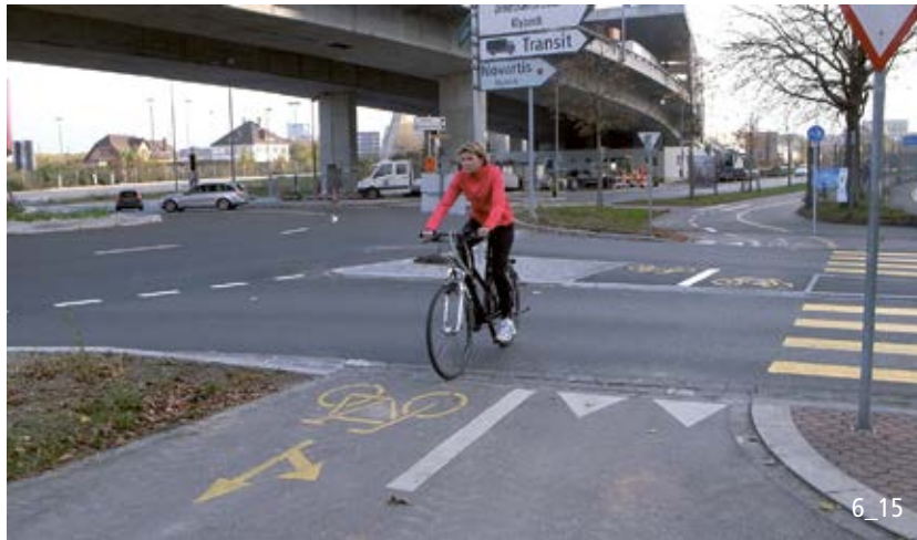
Zweirichtungsradweg mit nicht vortrittsberechtigter Querung.
