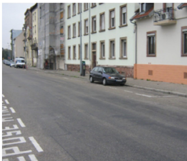
fig. 5 : rue de Fouday avant et après réaménagement
