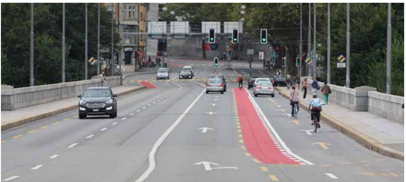
fig. 1 : ni particulièrement raide ni particulièrement étroit - le Lorrainebrücke à Berne. La modification des surfaces de circulation sur le pont se fera en plusieurs étapes : à partir de 2019, la bande cyclable sera élargie à 3,00 m ; d'ici 2025, la bande cyclable du milieu sera réaménagée sur le côté droit de la chaussée.
