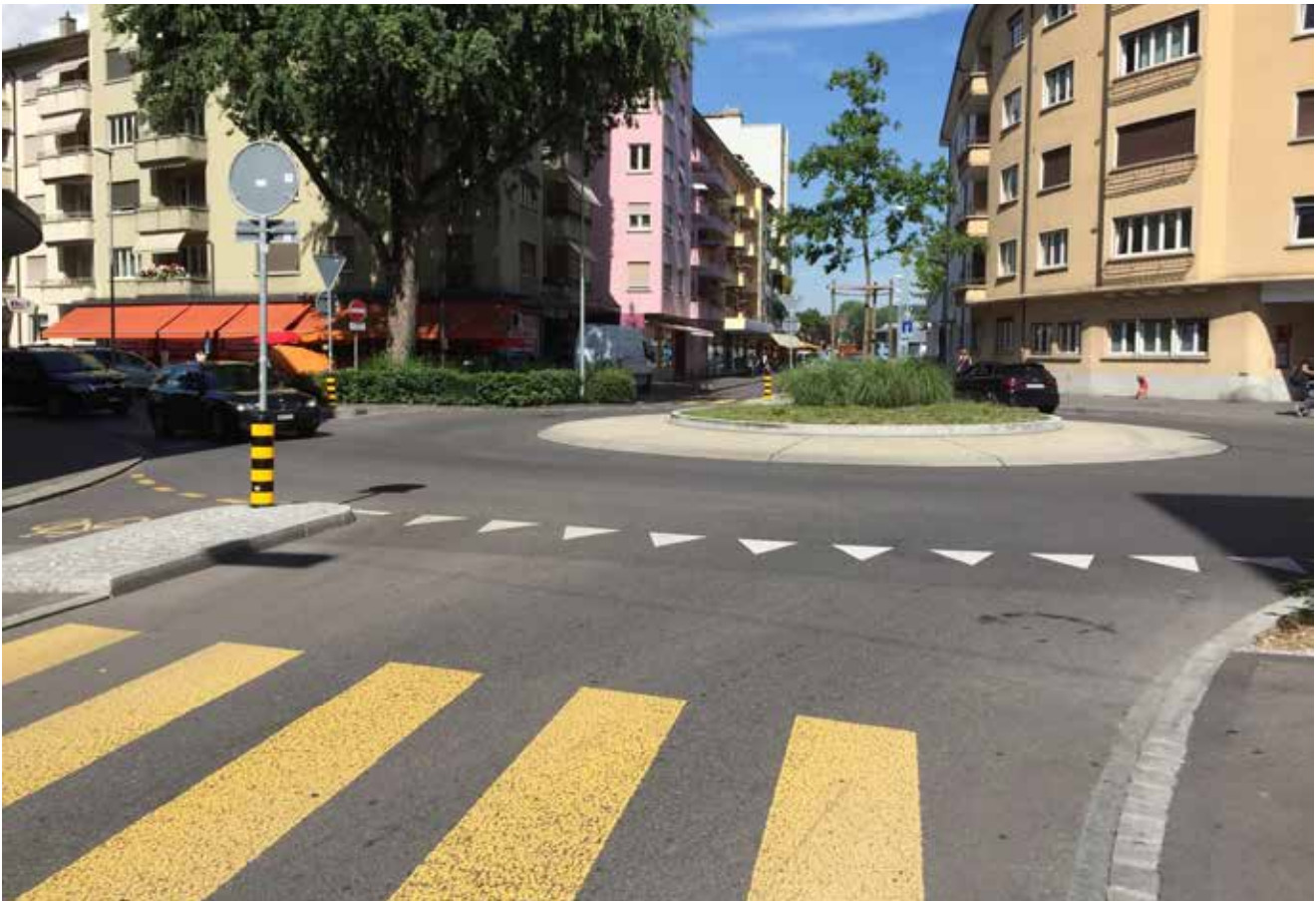
fig. 5 : giratoire de petite taille au centre-ville avec anneau intérieur bien démarqué et facilement reconnaissable (Bienne, rue des Marchandises – rue de Morat)
