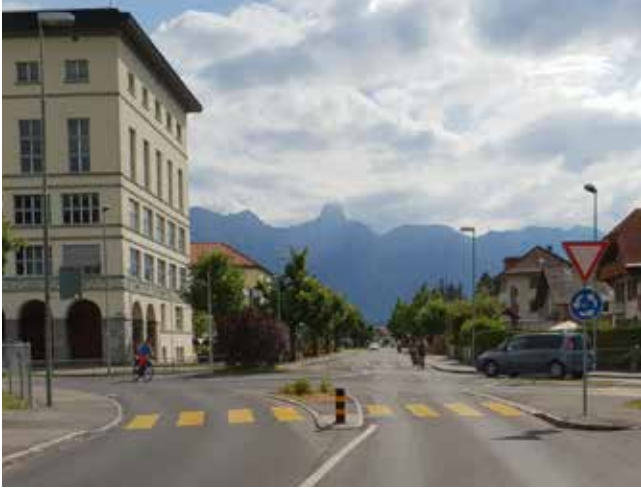
fig. 1 : voie d'entrée dans un giratoire sans déflexion et avec une trajectoire directe évidente (giratoire de la Pestalozzistrasse à Thoune, projet de réhabilitation par B+S AG en cours)
