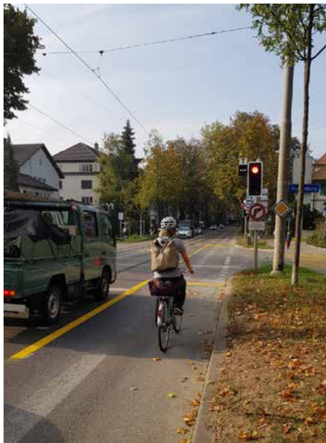
fig. 2 : bande cyclable large à la Muristrasse. Le nouveau marquage d'environ 2,40 m de large a été relativement simple à mettre en place.
