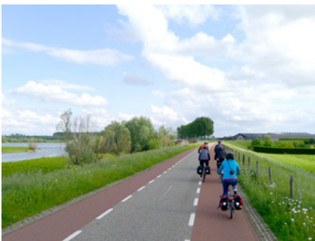
Abb. 4 Kernfahrbahn ausserorts Niederlande (Foto: planum biel ag)
