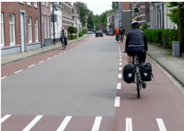
Abb. 2 Kernfahrbahn innerorts Niederlande (Foto: planum biel ag)
