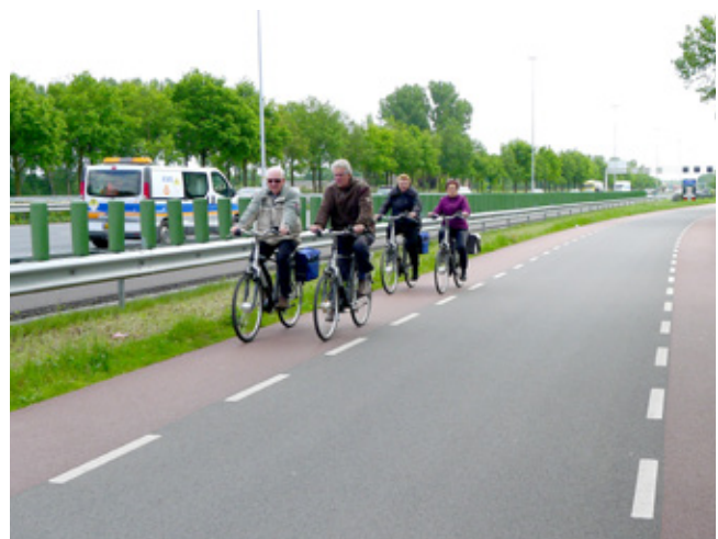
Abb. 5 Kernfahrbahn ausserorts Niederlande (Foto: planum biel ag)
