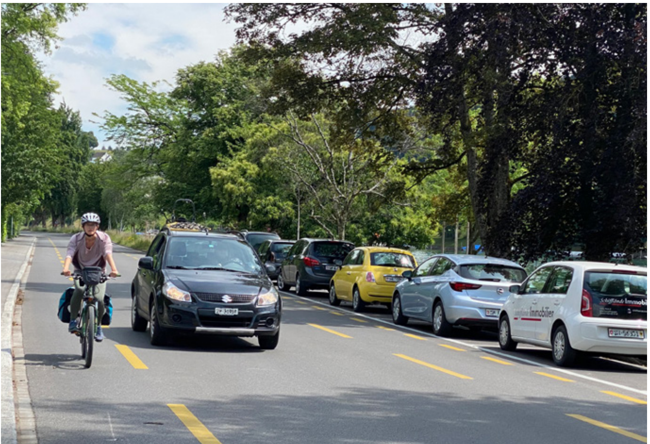
Abb. 8 Kernfahrbahn Schaffhausen (Foto: Kathrin Hager)
