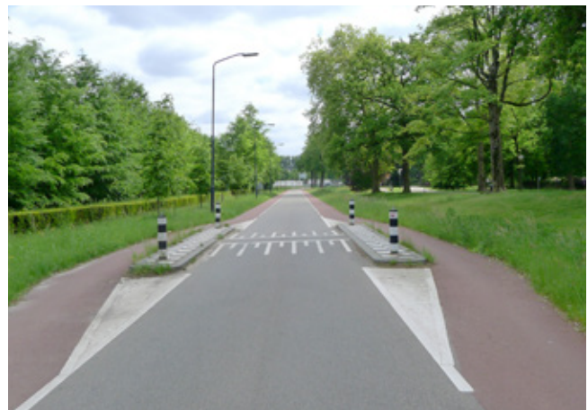
Abb. 3 Kernfahrbahn ausserorts Niederlande (Foto: planum biel ag)
