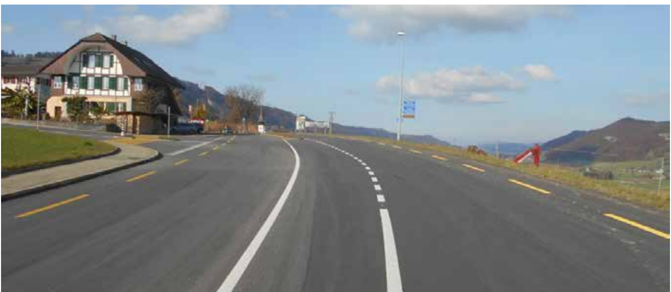
Figure 4 : Vue en direction de Berne, situation à l'arrivée (photo TBA, canton de Berne)
